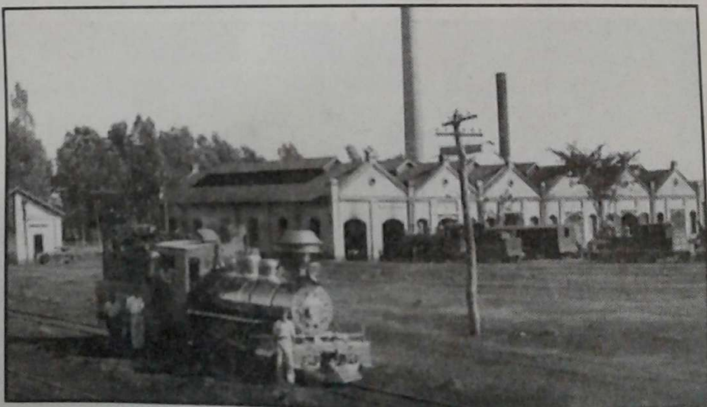
Pátio das locomotivas, oficinas e almoxarifado
